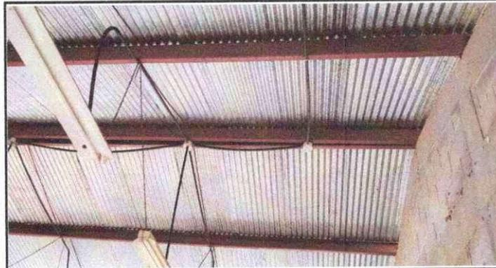
Foto 2: Se observan las estructuras portantes del modulo 1
