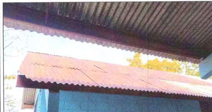
Foto 3: Se observa el deterioro de las laminas portantes del modulo 2.
